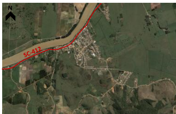
FIGURA 4: IMAGEM AÉREA DA ÁREA URBANA DO CENTRO, NO ANO DE 2003
