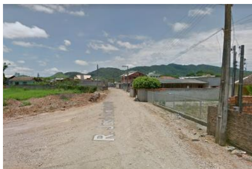
FIGURA 15: RUA JOSÉ DOMINGOS FILHO – LEITO NATURAL
