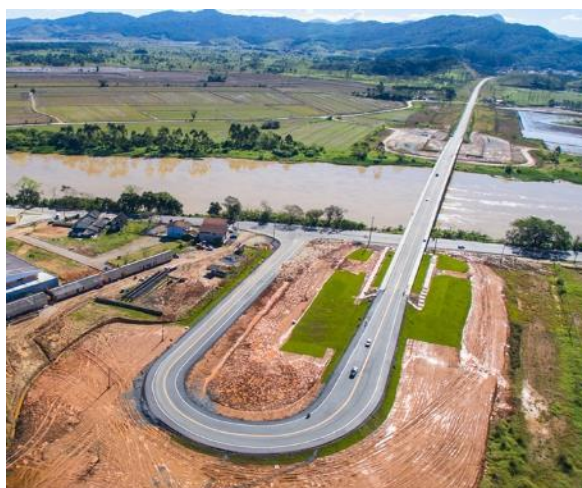
FIGURA 1: PONTE DE ILHOTA
