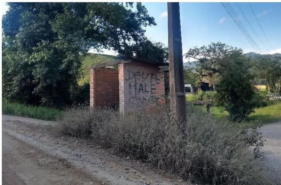
FIGURA 19: PONTO DE ÔNIBUS EM ALVENARIA NA ÁREA RURAL
