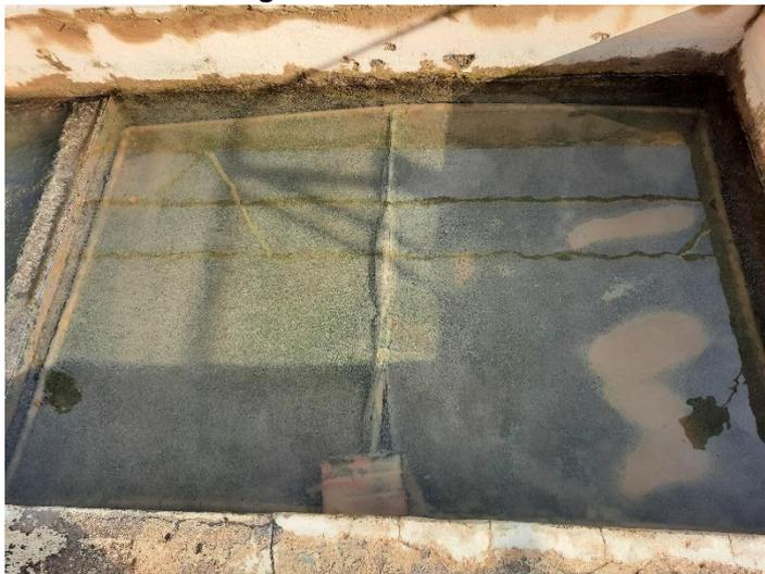
Por fim, após a etapa de decantação, a água passa pelo processo de filtração, cuja etapa é composta por 4 filtros descendentes com material filtrante composto por areia, seixo filtrado e carvão ativado, sendo a carreira de filtração de aproximadamente 24 horas. Esta etapa apresenta-se em bom estado de conservação, como pode se verificar na Figura 14.
