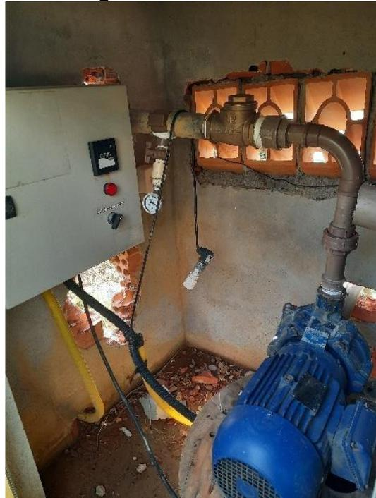
O acionamento do conjunto moto bomba é realizado por sistema de partida direta, automatizado por de timer. A água recalçada atende todo o bairro Minas até o abastecimento de um pequeno reservatório de jusante com capacidade de 20 m<sup>3</sup>, demonstrado na Figura 24.
