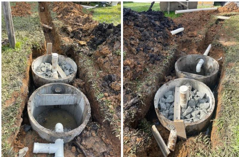
O sistema composto de fossa séptica seguido de filtro anaeróbio atende teoricamente o pré-requisito de redução da carga orgânica que a legislação ambiental exige, porém na prática estes sistemas possuem as seguintes dificuldades:
