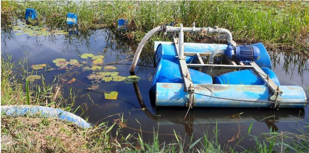
O sistema de adução de água bruta da captação à ETA Pedra de Amolar conta ainda com uma estação de recalque de água bruta intermediária, a qual é composta de um tanque pulmão de 5 m<sup>3</sup> e conjunto moto bomba de eixo horizontal, vide a Figura 31 e a Figura 32.
