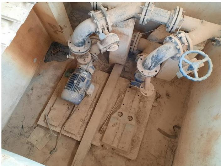
Como pôde ser visto acima, a área onde está localizado o Booster encontra-se em inadequado estado de conservação, não havendo estrutura de guarda corpo e escada fixa de acesso ao CMB. O acionamento do CMB se dá por sistema de partida direta, como mostra a Figura 33.
