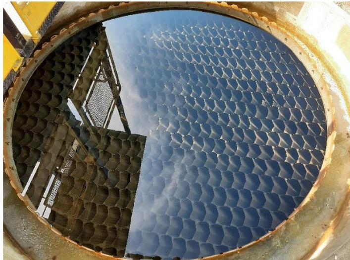
Por fim a água passa pelo sistema de filtração composto por 4 filtros do tipo fluxo descendente, conforme a Figura 38, antes de passar pela etapa final de desinfecção pela adição de cloro e flúor no tanque de contato.
