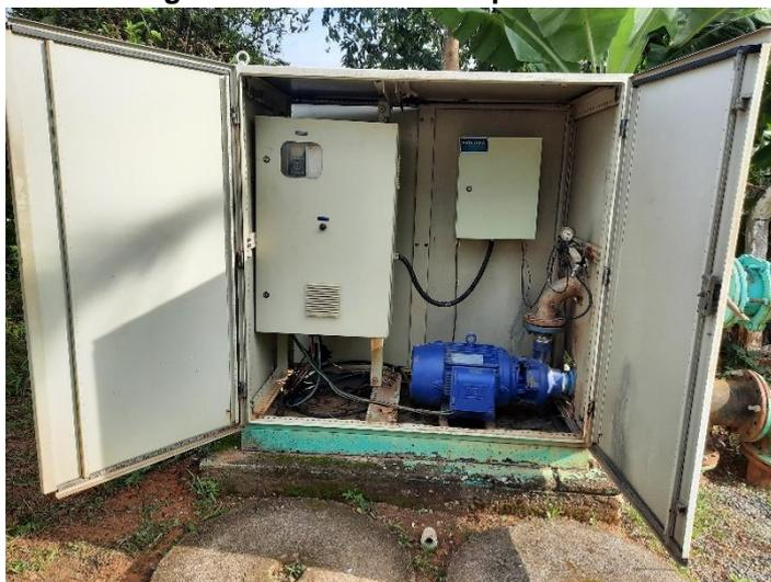
O acionamento do conjunto moto bomba é realizado por meio de inversor de frequência, vide a Figura 21.
