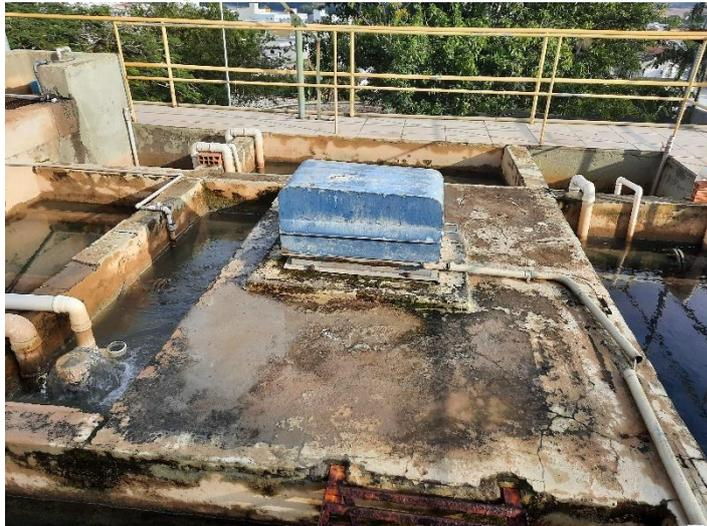
Após o processo de floculação, a água passa para a decantação ascendente de alta taxa. O sistema de decantação é composto por 4 decantadores que trabalham em paralelo, sendo necessária a realização de limpeza semanal para manter o bom funcionamento desta etapa de tratamento. Os decantadores se apresentam em inadequado estado de funcionamento, como pode ser visto na Figura 13.
