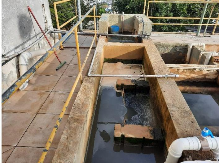
A etapa de floculação é mecanizada, com adição de polímero para auxiliar na formação dos flocos, como pode ser visto na Figura 12. Há ainda a necessidade de limpeza semanal do floculador para garantir uma melhor eficiência no processo.
