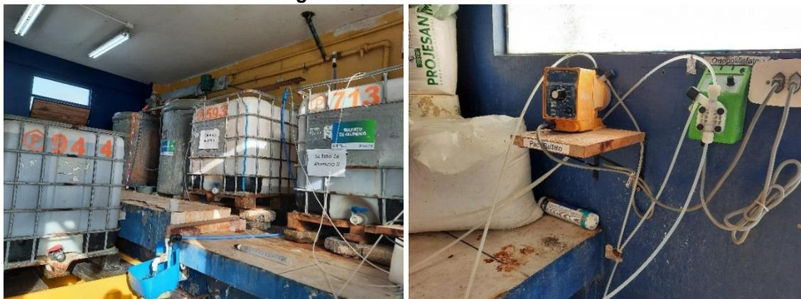
A ETA não possui macromedição em tempo real, sendo realizado por régua no vertedouro de chegada a cada 2 horas e não existe tratamento do lodo gerado na ETA, sendo este lançado no sistema de drenagem. A estrutura civil do prédio da ETA se encontra em adequado estado de conservação, como pode ser visto na Figura 16.
