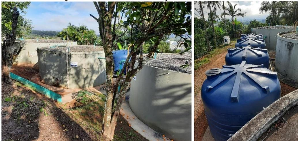
A medição de nível dos reservatórios se dá por piezômetro e todas as unidades se apresentavam em adequado estado de conservação.
