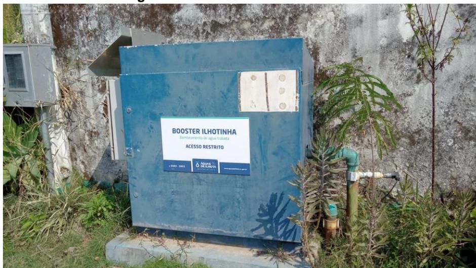
O CMB é composto de motor WEG, com potência de 5 CV, enquanto a bomba é uma Thebe com capacidade de recalque de até 9,7 m<sup>3</sup>/h a uma altura manométrica de 110 mca.
