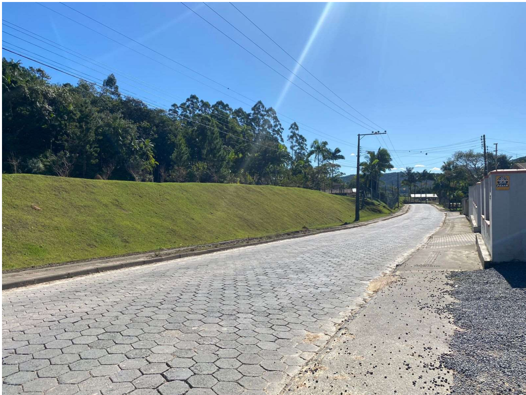
Figura 11 - Pavimentação na Rua Padre Roberto Wirobeck. Após a localização do empreendimento possui pavimentação em paralelepípedo. Fonte: Macro Ambiental.
