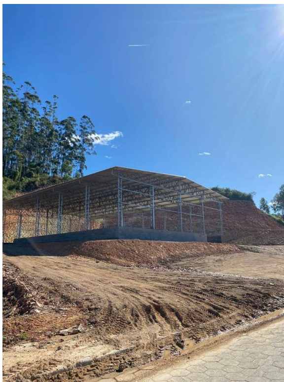
Figura 12 – Construção industrial sendo instalada dentro dos limites da AID do empreendimento. Fonte: Macro Ambiental.
