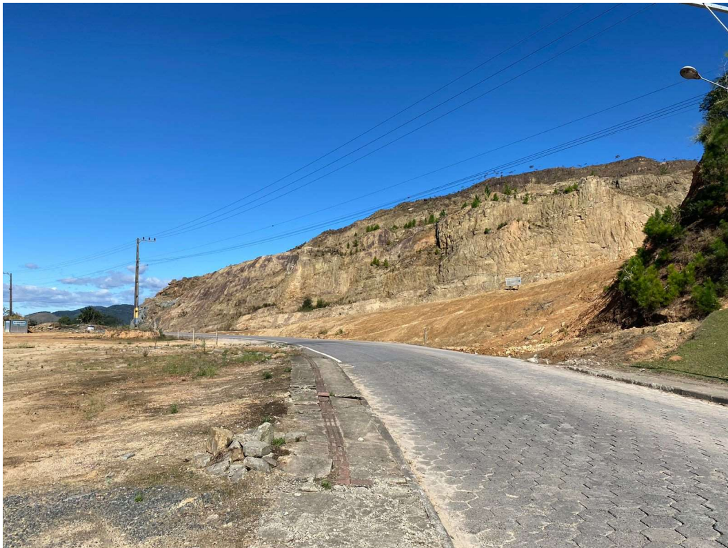
Figura 9 - Iluminação pública na Rua Padre Roberto Wirobeck. Fonte: Macro Ambiental.
