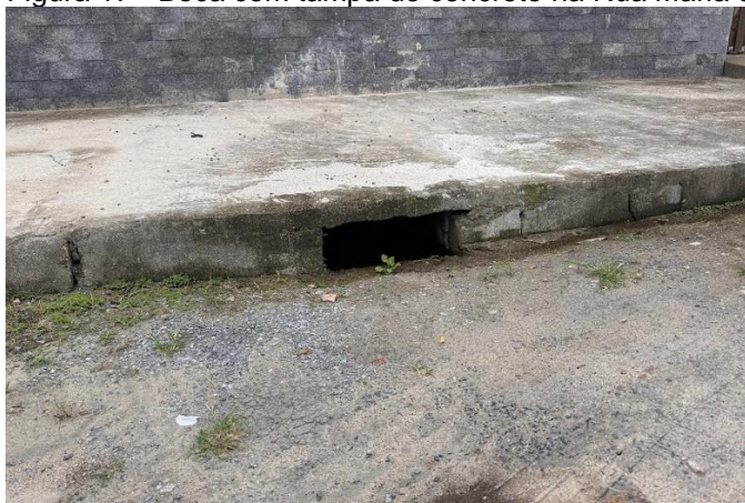
Figura 17 - Boca com tampa de concreto na Rua Maria de Oliveira Berti
