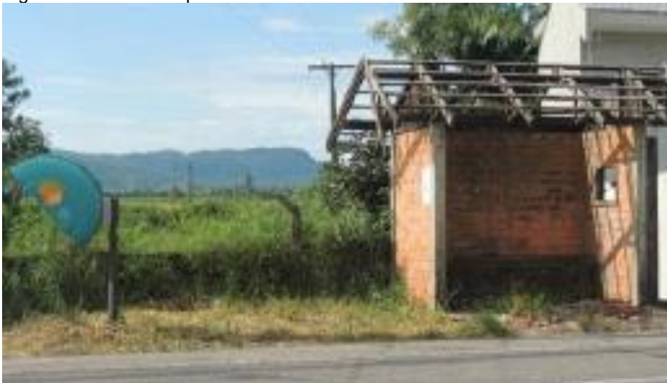
Figura 27 - Telefones públicos instalados na SC-412
