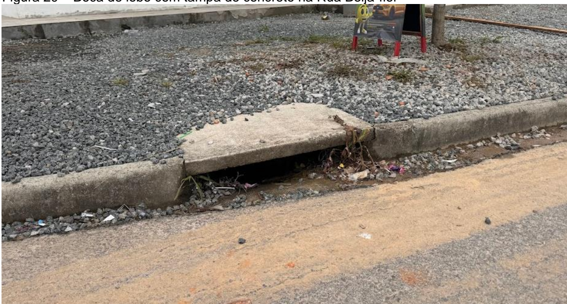
Figura 20 - Boca de lobo com tampa de concreto na Rua Beija-flor
