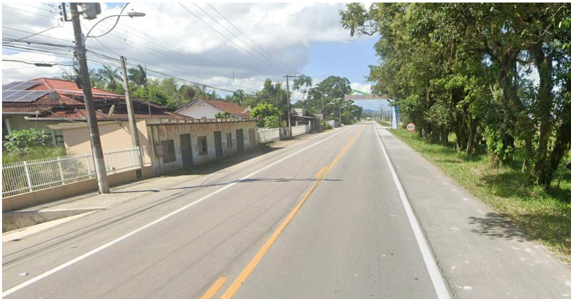
Figura 13 – Via de Acesso: Rodovia SC - 412.
