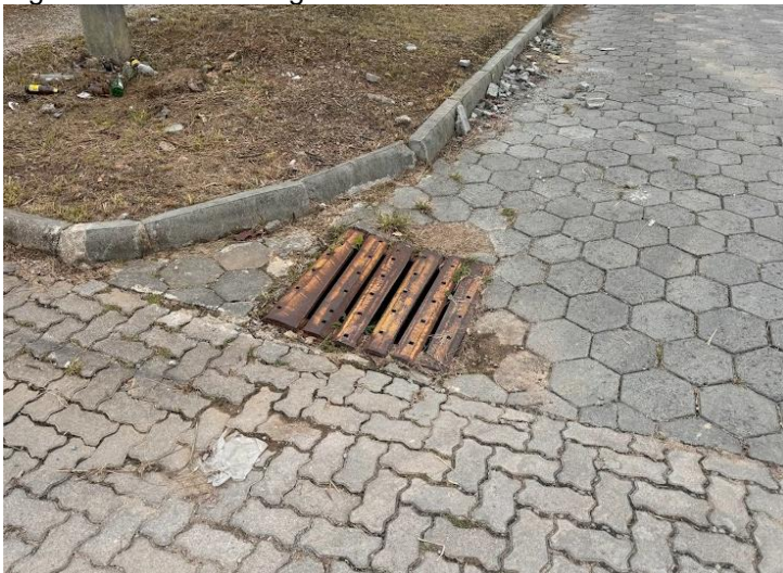
Figura 19 - Boca com grelha de concreto na Rua Devanir Bonfim da Fonseca
