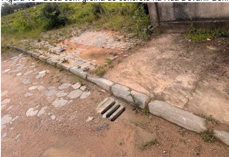
Figura 20 - Boca de lobo com tampa de concreto na Rua Beija-flor
