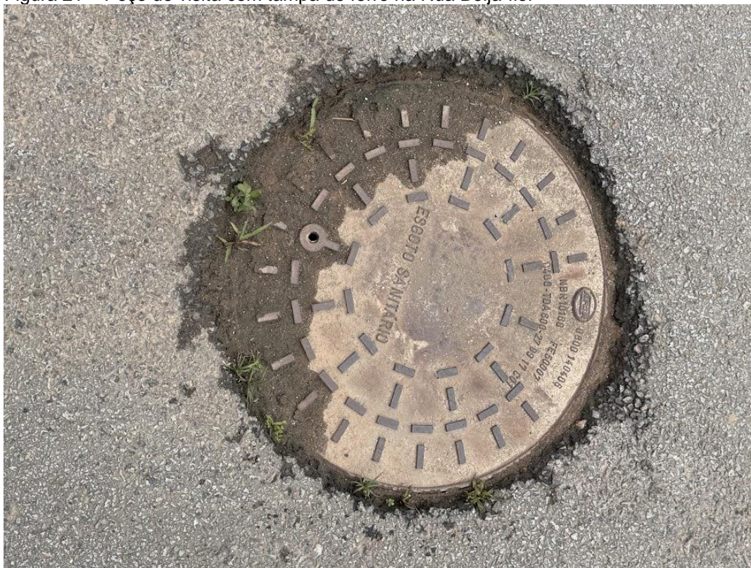
Figura 21 – Poço de visita com tampa de ferro na Rua Beija-flor
