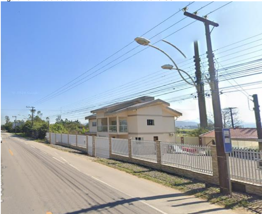
Figura 25 - Rede de alta e baixa tensão na Rodovia SC 412
