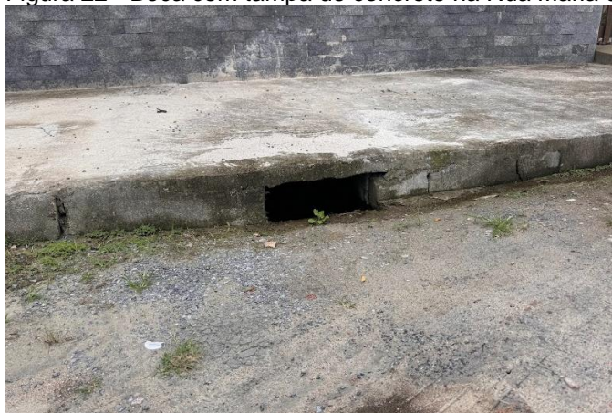
Figura 22 - Boca com tampa de concreto na Rua Maria de Oliveira Berti
