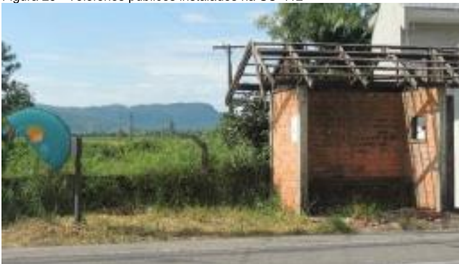
Figura 29 - Telefones públicos instalados na SC-412
