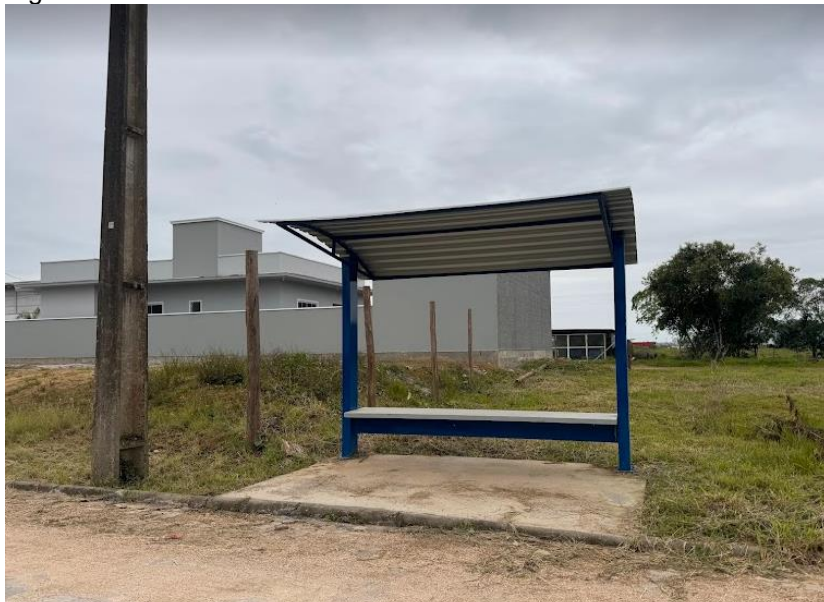
Figura 31 – Ponto de ônibus localizado na Rua Maria de Oliveira Berti
